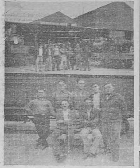
Las dos locomotoras que el Gobierno de Costa Rica ha obsequiado al de Nicaragua, y el personal técnico del Ferrocarril al Pacífico, que tendrá a su cargo el montaje de esas máquinas.
